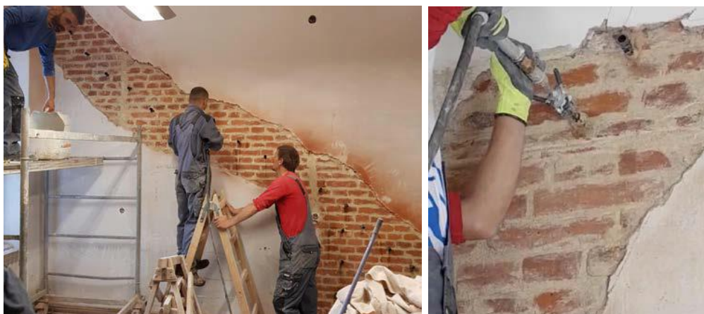
Prikaz postupka injektiranja zidova
